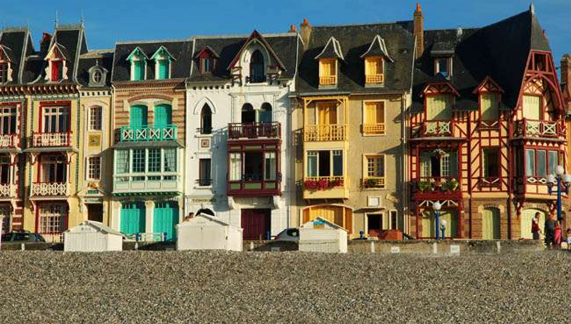
MERS LES BAINS – îlot d'immeubles préservés
